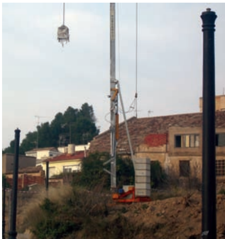
Farolas en la calle Almagrán, de las que el concejal de Fomento y Urbanismo, Ángel Berga, asegura que han sustituido y reparado en varias ocasiones y que están en buen estado.
